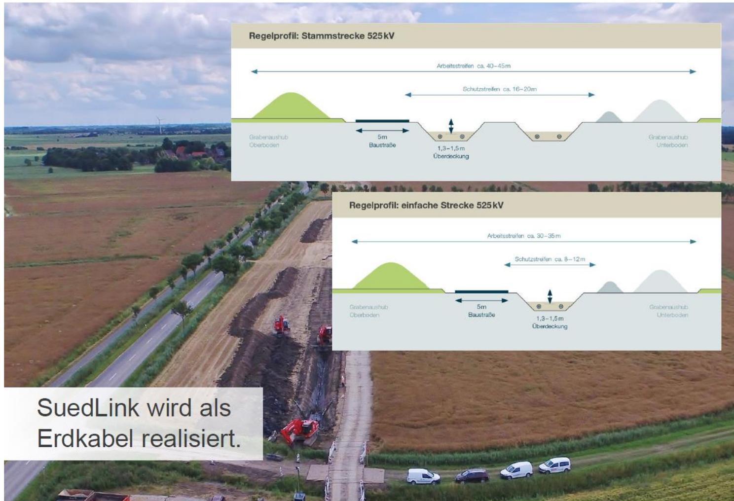
SuedLink wird als Erdkabel realisiert.
