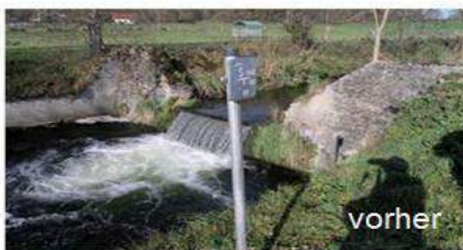
Absturzbauwerk Höhe 2,3 m
