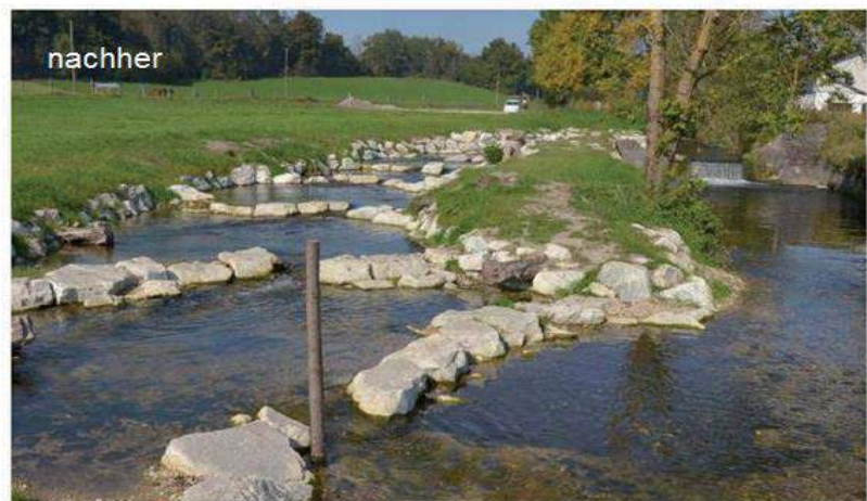
Neues Umgehungsgerinne, Länge 48 m, 7 Becken in aufgelöster Bauweise, mind. 100 l/s, Ersatzlebensraum mit variablem Strömungsmosaik
